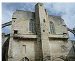
Façade ouest, partie haute
