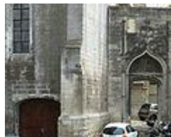
Porte au décor flamboyant et reste du mur de clôture
