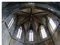
Voûte et partie haute de l'abside
