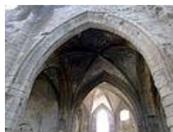
Croisées d'ogives des collatéraux et chapelles sud
