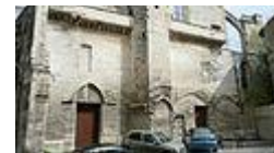
Façade ouest, partie basse
