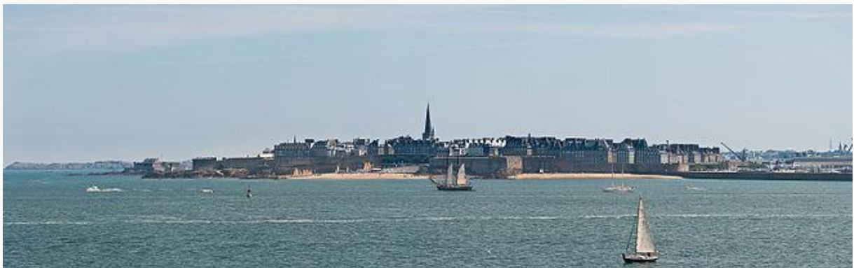
Vue de la ville fortifiée du sud-ouest.
